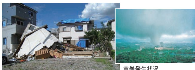
竜巻により倒壊した住宅
