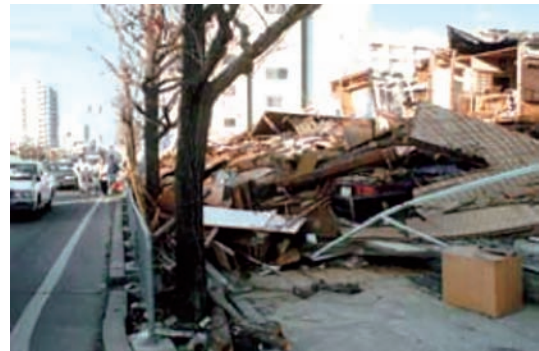
1階部分が倒壊した家屋(近畿地方整備局HP)
