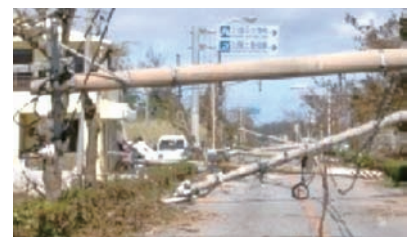
台風14号の強風で倒壊した電柱 (宮古島地方気象台 HP)
