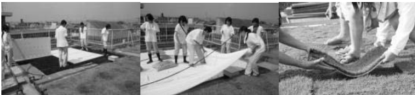
写真5 左：スチレンボードの設置 中：導水シート設置 右：芝マットの張りつけ
