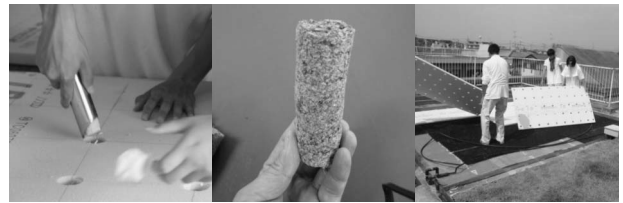
写真2 左：ハイブリッドベースマットの制作 中：キューブ 右：K-NETの設置
